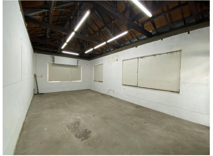
17. ▲Z103(中華路一段2號2樓 儲藏室)
